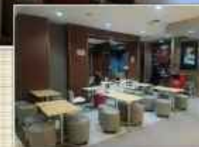
RENOVASI KFC GRAND METROPOLITAN MAL BEKASI
